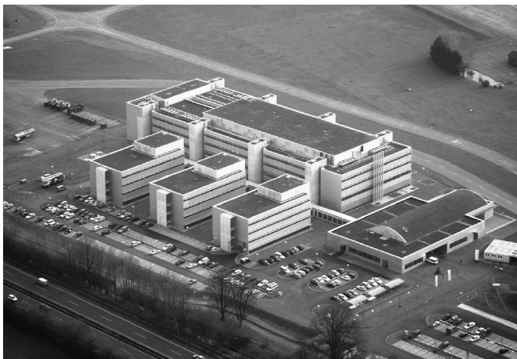
Das Flugsicherungszentrum der Skyguide in Wangen bei Dübendorf.
