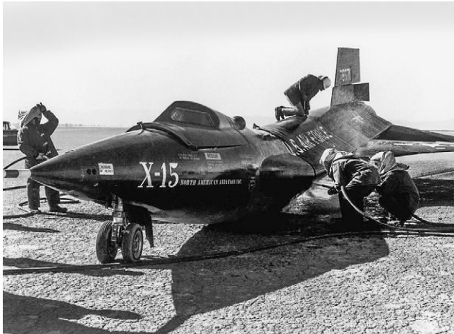
Zellenbruch nach Bugfahrwerksproblem.
