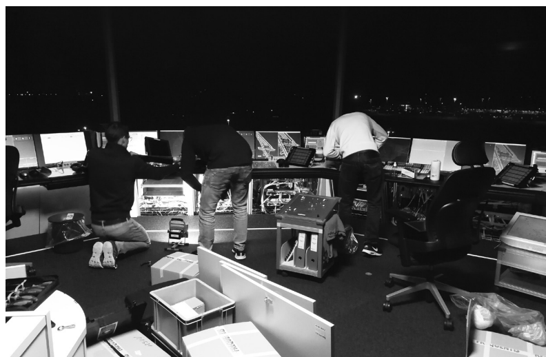
Unterhaltsarbeiten in der Tower-Kanzel.
