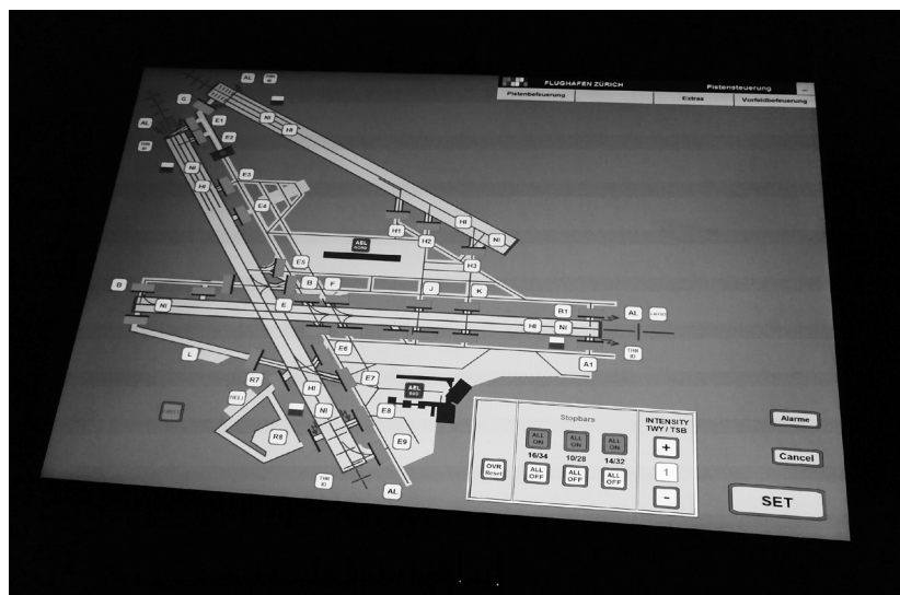
Das Panel für die Steuerung der Beleuchtungssysteme.
