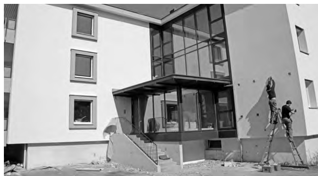
Der Eingang zu den AEROPERS-Büros.
