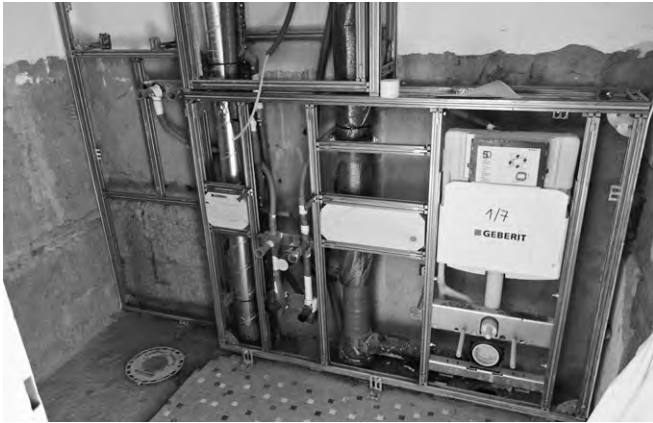
Neuer Sanitärblock für die Mietwohnungen.
