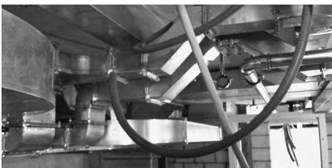
Wer hat da den Durchblick? Neuer Technikraum mit Lüftungsanlage.
