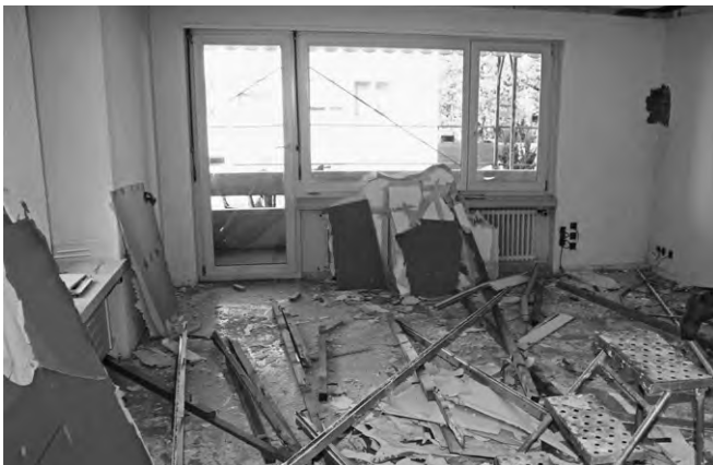
Auch so können «Vorbereitungsarbeiten» aussehen.
