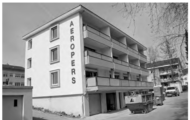
Die Südwestseite des renovierten Gebäudes.
