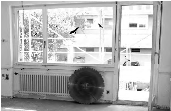
Mit einem Riesenfräsblatt werden die Balkonbrüstungen abgetrennt.
