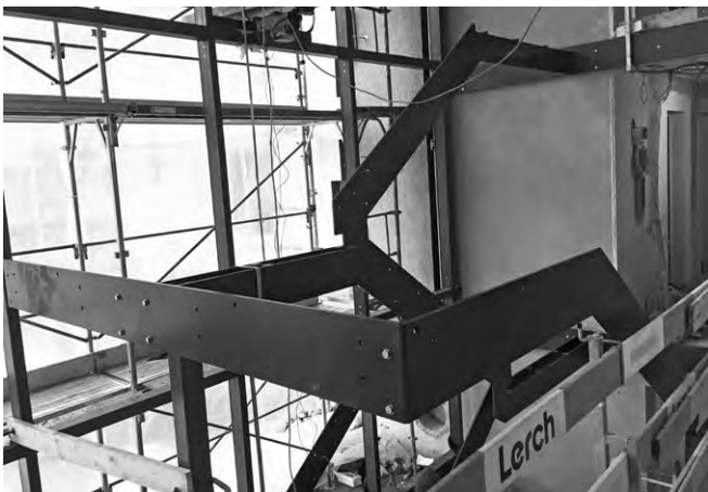
Stahlkonstruktion für neues Mietertreppenhaus.
