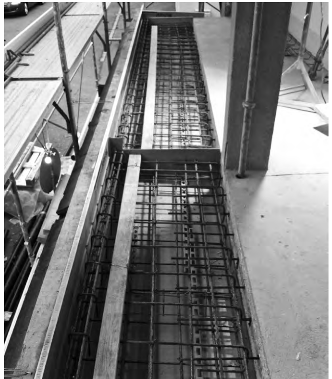
Vorbereitung für die Balkonverbreiterung des Büros.
