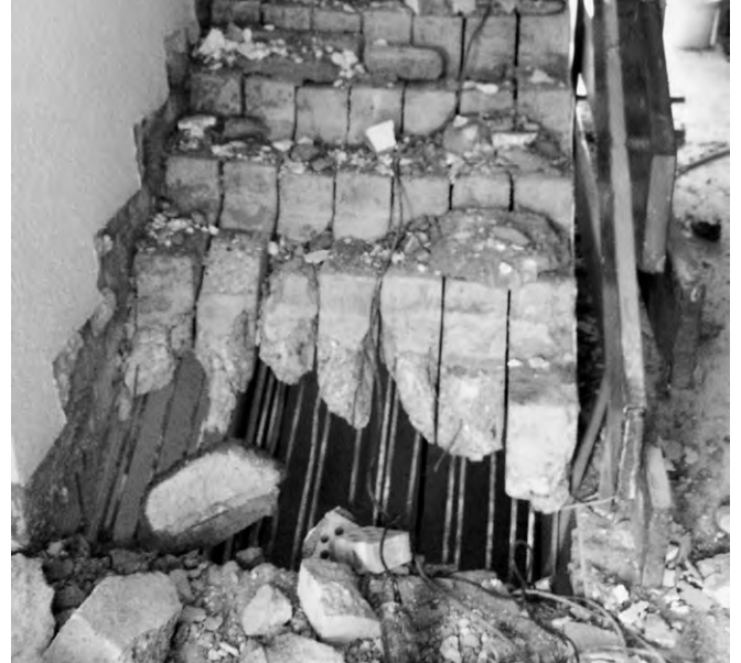
Abbruch der Treppe vom Erd- ins Obergeschoss.
