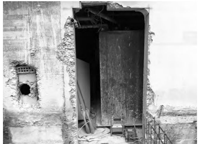
Durchbruch zum Tankraum, in dem sich neu die Mieterkeller befinden.
