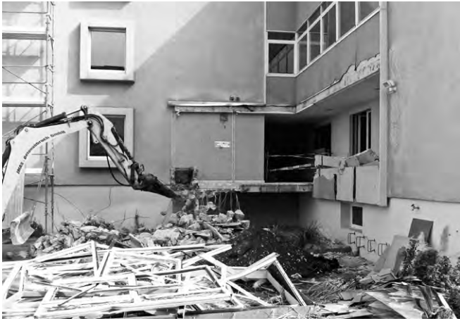
Beginn der «Vorbereitungsarbeiten».
