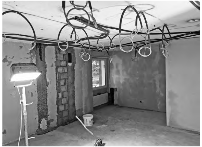
Kabel, so weit das Auge reicht: altes Vorstandszimmer.
