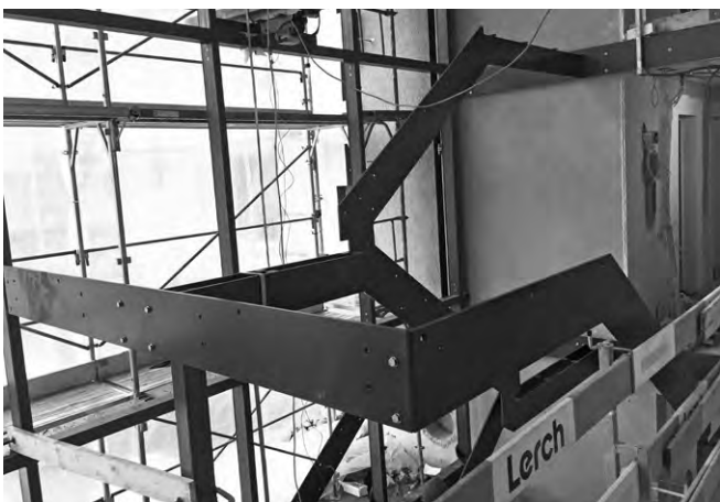
Stahlkonstruktion für neues Mietertreppenhaus.
