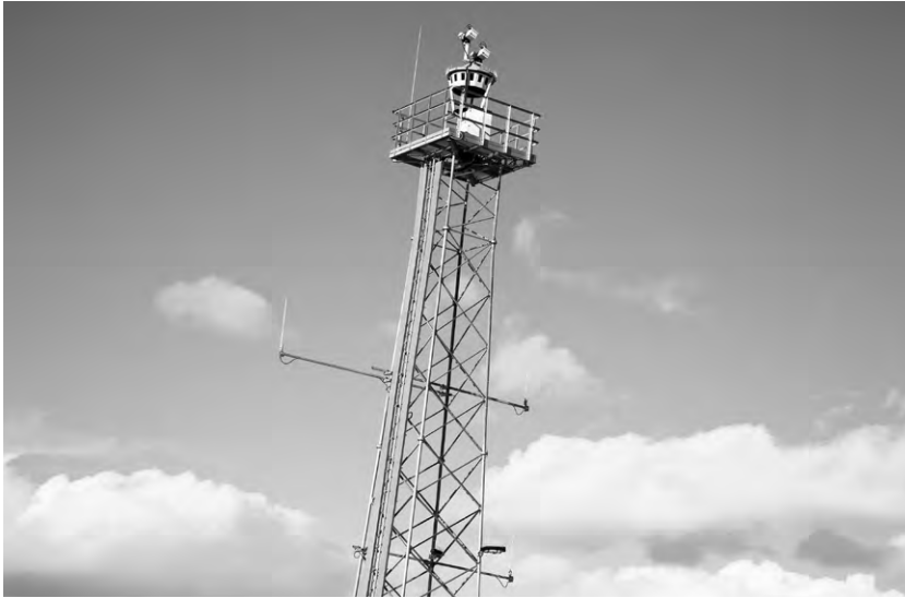
Kamerainstallation am Flugplatz (© LFV).
