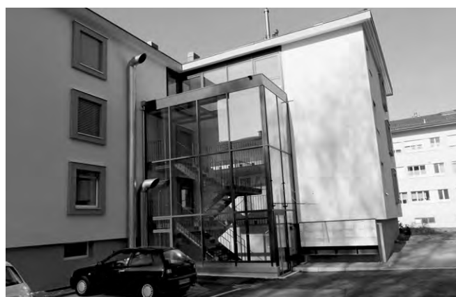
Der neue Eingang mit Treppenhaus für die Mieter.
