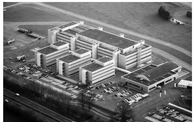
Die Skyguide-Gebäude in Wangen/Dübendorf aus der Vogelperspektive.
