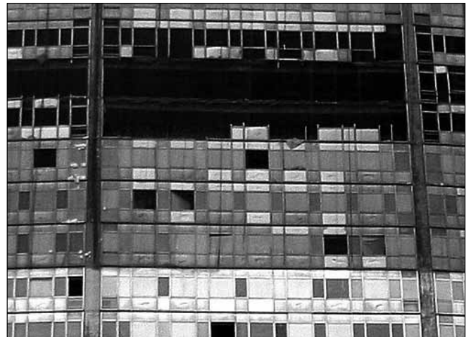
Der Pirelli Tower nach dem Absturz.
