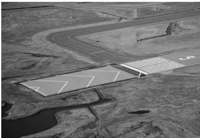
Das EMAS bremst Flugzeuge beim Runway Overrun kontrolliert ab und bewahrt sie vor grossen Schäden.
