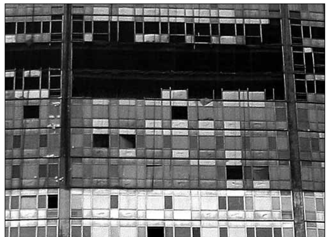
Der Pirelli Tower nach dem Absturz.
