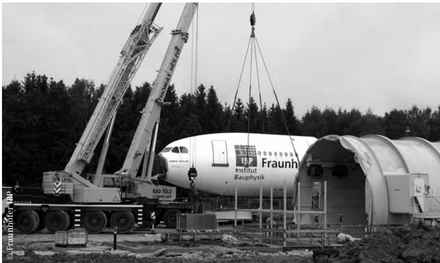
Aufwendig: Einbau eines A310-200-Rumpfs in die Druckkammer in Holzkirchen.
