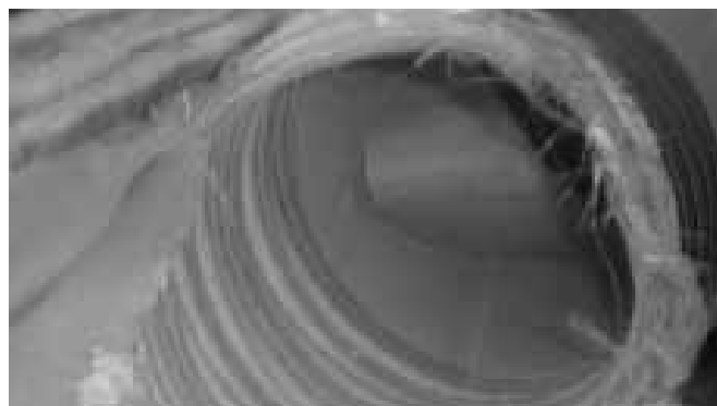
Neuer Duct mit saubereren Innenwänden.
